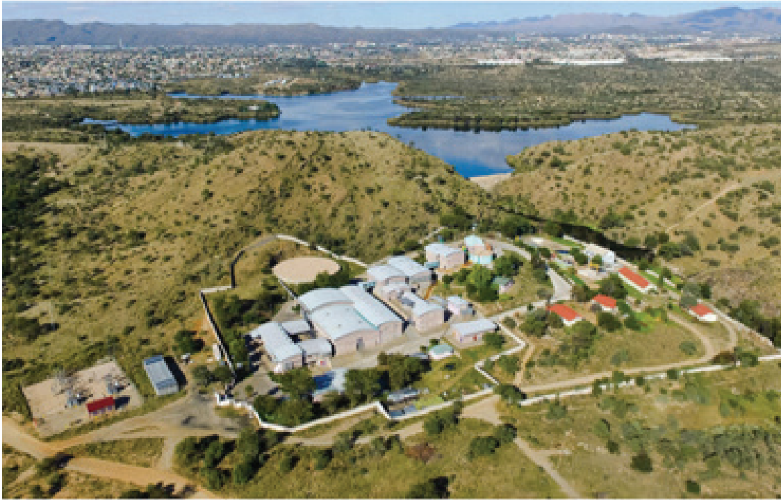
Namibia: Windhoek Atık Sudan İçme Suyu Arıtma Tesisi (5)
